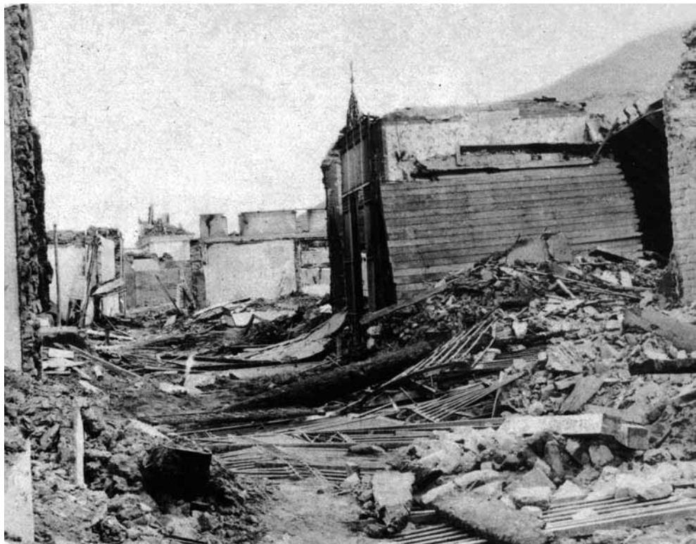
[Foto 04] Hospital “San Juan de Dios” en calle Baquedano de Arica, luego de ser destruido por un terremoto.
